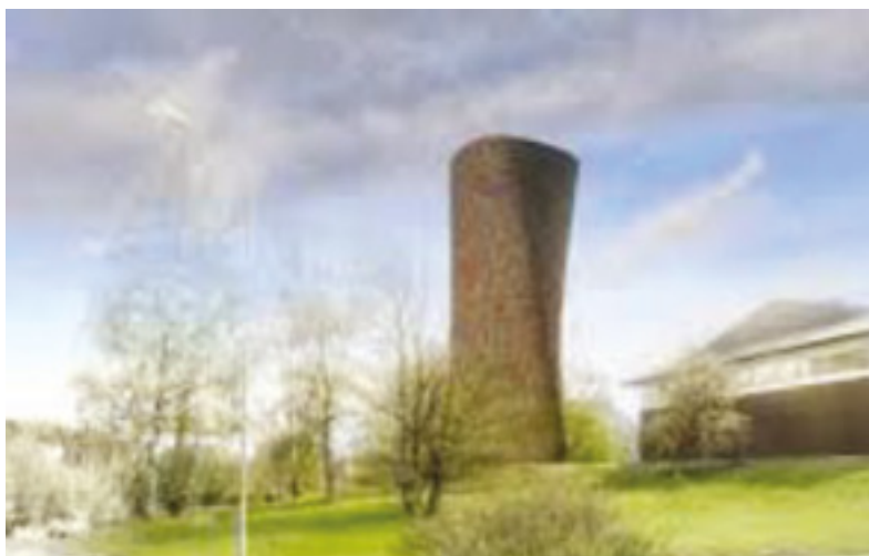
Ilustración 31 – Chimenea para la salida de aire contaminado situada aguas arriba de la boca del túnel. Enlace Estocolmo norte
